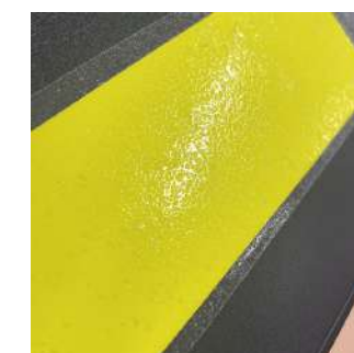
すべり止めフィルム貼り付け
