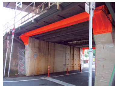
コンクリート桁下 ロイヒカラーネオ使用
