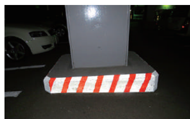
駐車場 縁石 ビームライトエース使用
