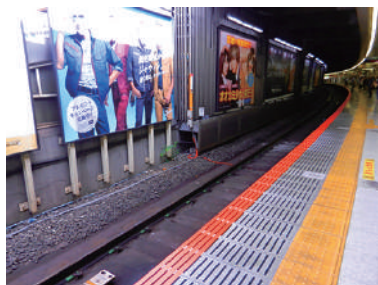
鉄道駅舎 ホーム先端部分 ルミライン#100使用
