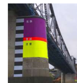
橋脚 量水標 スーパーミノVトップ使用
